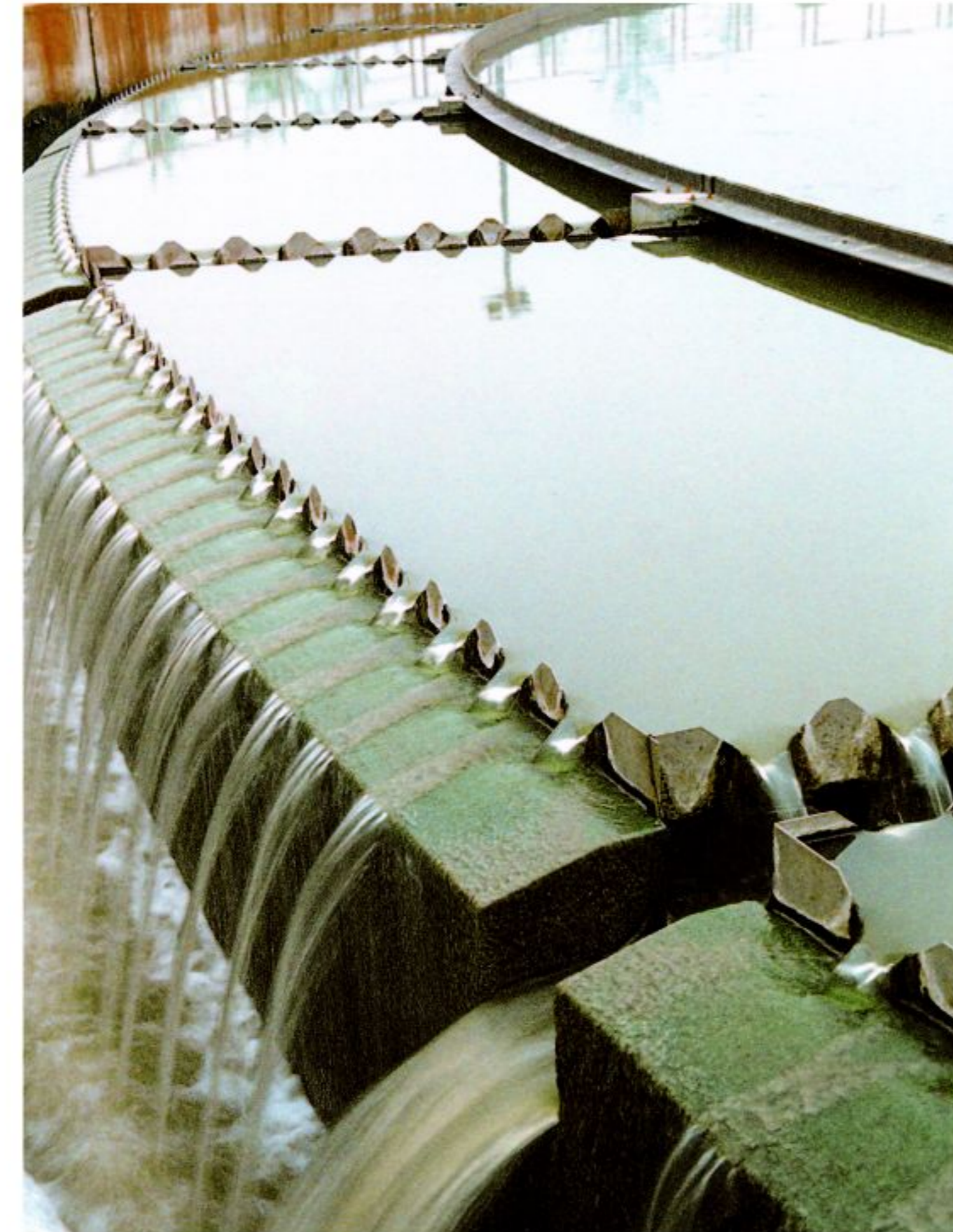
污水处理 Sewage treatment plant
